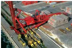
図 倒壊したコンテナクレーン
