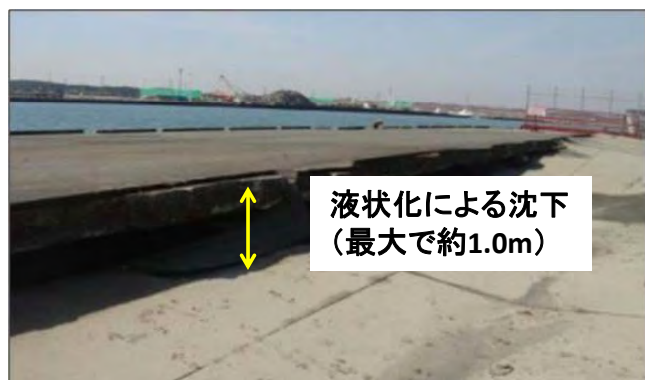
茨城港(日立港区) 第4ふ頭岸壁(-12m)
