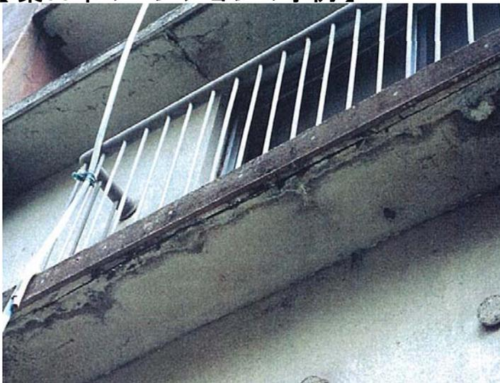
バルコニーに大きなひび割れが生じている。
