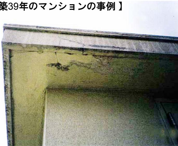
庇に大きなひび割れや剥落跡がみられ、鉄筋が露出している個所もある。
