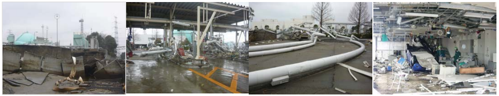
南蒲生浄化センター(下水処理施設)
