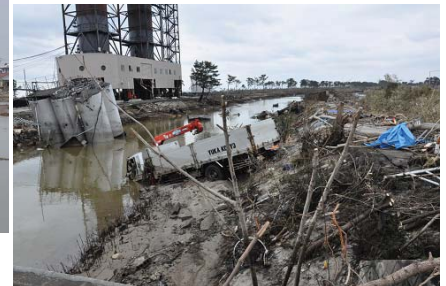
高砂南部排水機場 (宮城野区蒲生)
