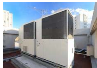
ガスヒートポンプ冷暖房システム(室外機と室内機)
