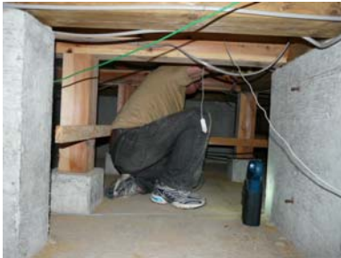
床下点検：温度取りと含水率測定
