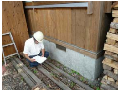
専門家による住宅診断中
