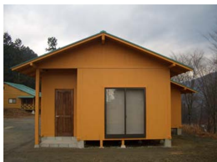
完成した試験棟
