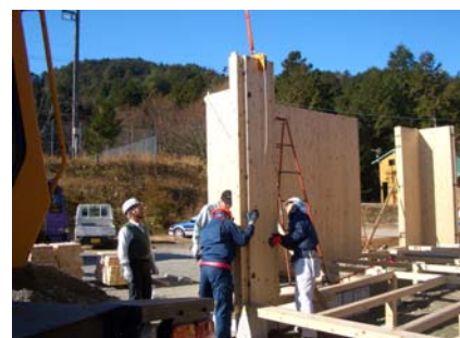
パネルの建て込み
