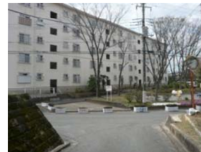
エレベーター未設置の住棟
