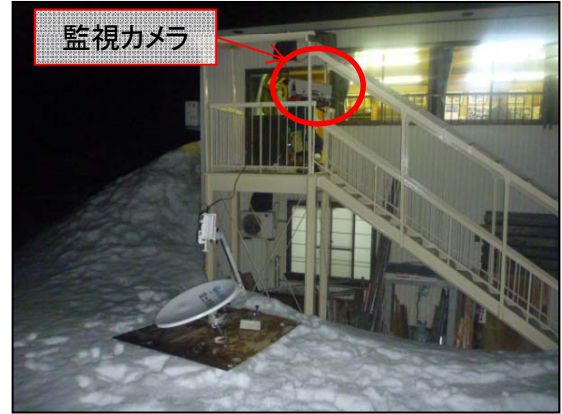
監視カメラ・Ku-Sat設置状況
