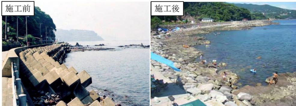
図表 3-4-1 消波ブロックを除去し、自然石を配置することで荒天時の高潮対策を図った海岸の例
