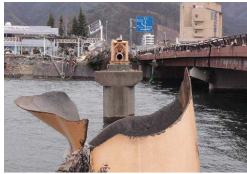
写真Ⅰ-1-7 岩手県釜石市 矢ノ浦水管橋被害状況
