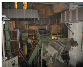
機械・電気設備水没、全機能停止 (沈砂池搬出機)
