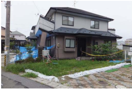
A地区 における被害（のり面の崩壊による背後家屋傾斜）
