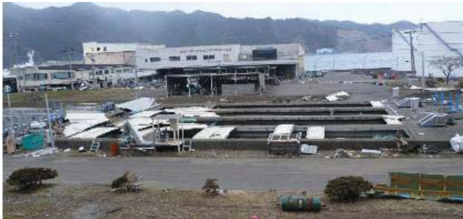
写真 I-1-11 大平下水処理場（F R P 覆蓋の流出）
