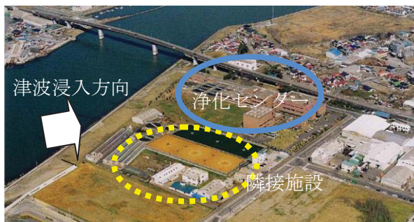
写真 I-1-15 石巻東部浄化センター (津波浸入方向に隣接施設有り)
