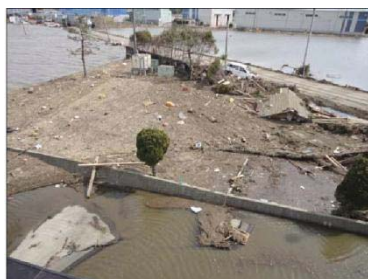
津波による建屋損傷、周囲浸水
