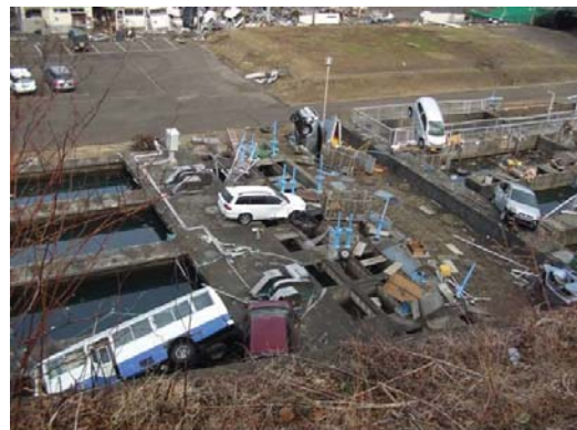
写真 I-1-14 大平下水処理場 (水処理施設への車両浸入)
