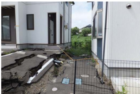
C地区における被害（沼の埋立地の液状化による家屋被害）
