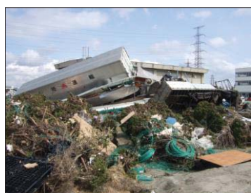
ポンプ場南西部車両漂流物
