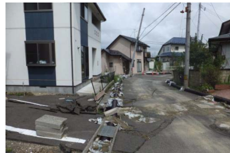
C地区における被害（沼の埋立地の液状化による家屋被害）
