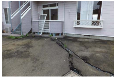
A地区 における被害（のり面の崩壊による背後家屋傾斜）
