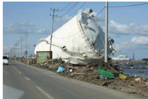
県南浄化センター（汚泥燃料化施設） 県南浄化センター（ガスタンクの流出）
