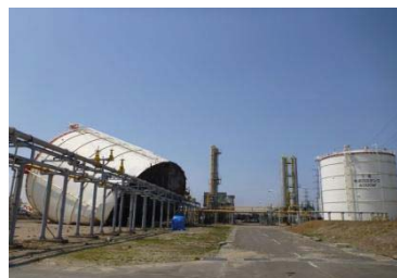
転倒したガスタンク
