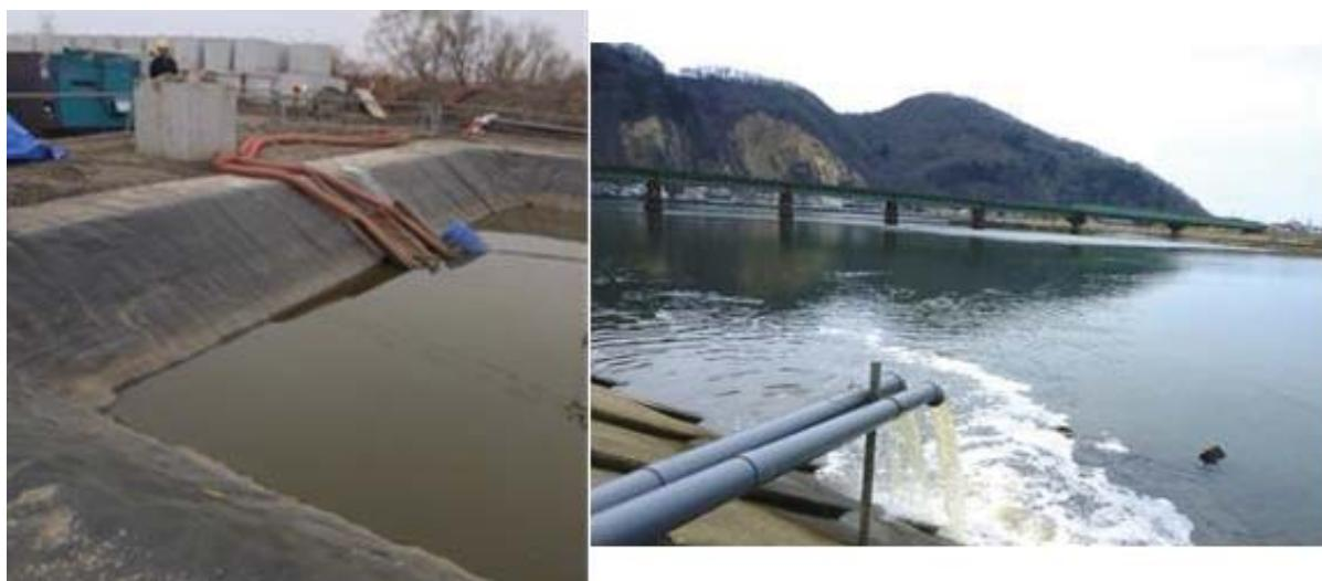
汚水ポンプ場(停止中)付近で簡易沈殿処理、消毒後、本川まで導水して放流(旧北上川(石巻市内))
