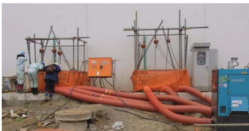
写真 I-1-32 流入渠からの仮設ポンプによる汚水くみ上げ
