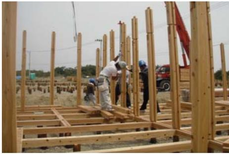
120mmの柱に溝が掘られ板が落とし込まれる
