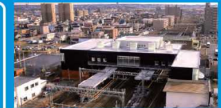
JR白石駅周辺地区整備▲
