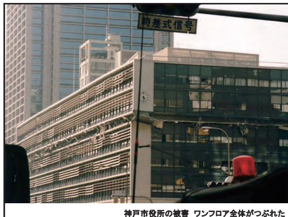
神戸市役所の被害 ワンフロア全体がつぶれた
