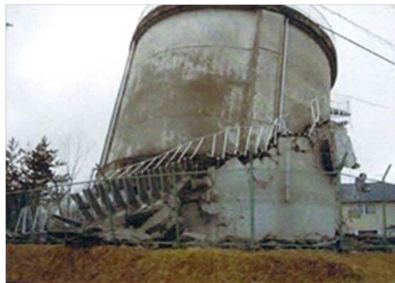
一関市沢配水池
