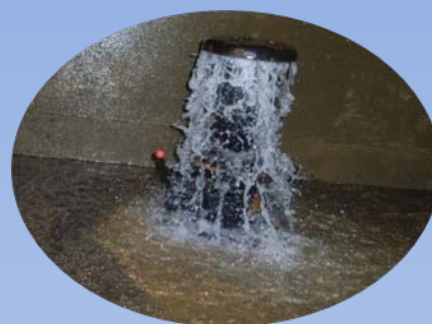
空気弁の破損
