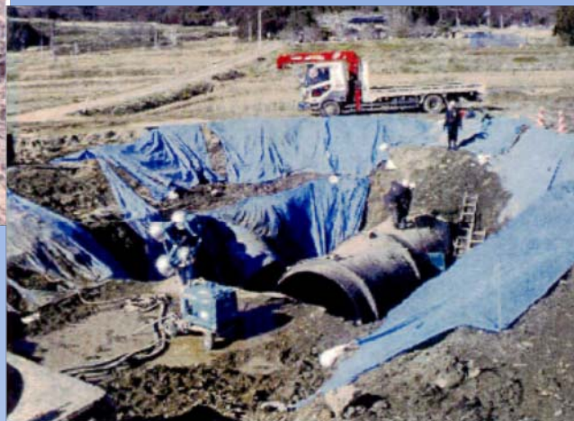
県広域水道φ2400の修繕状況
