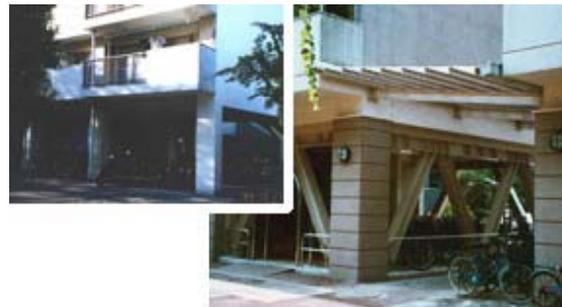
耐震補強工事 左 鉄骨ブレース補強 右 耐震壁増打補強
