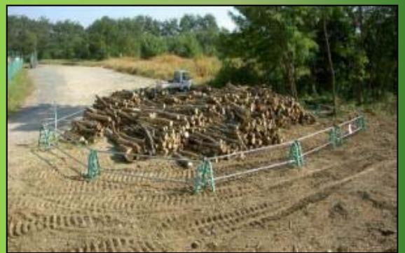
流下障害となっているため伐開した樹木
