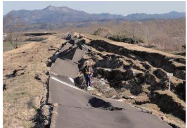
液状化により被災した河川堤防の復旧方法に関する技術的助言
