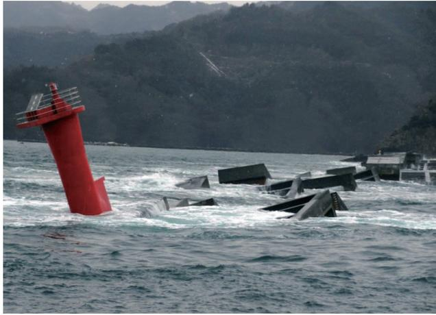
釜石港湾口防波堤の被災状況
