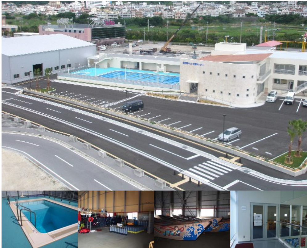
写真－7 宜野湾マリン支援センター
