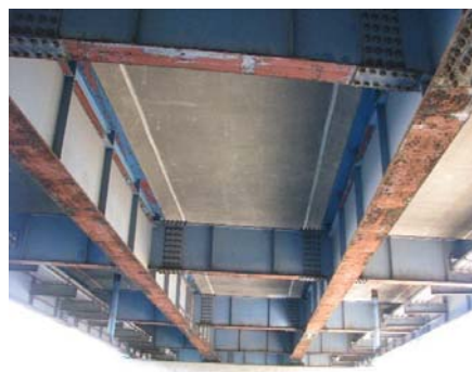
鋼桁の防食機能劣化
