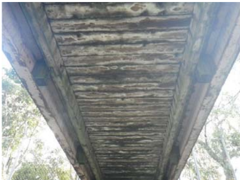
床版（木）の腐朽
