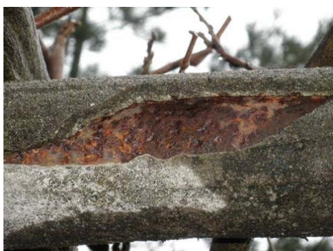
梁部鋼材露出
