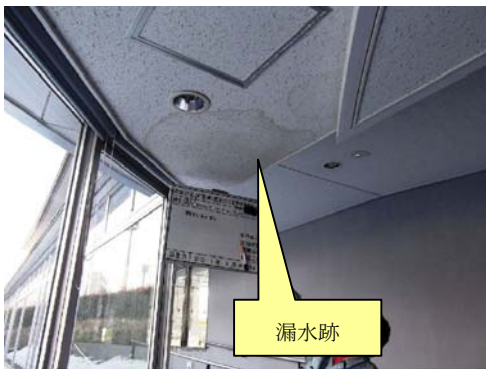
天井の雨漏り
