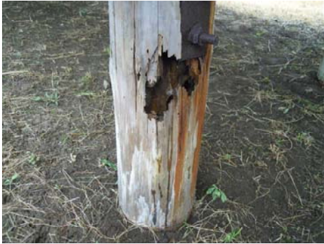
橋脚柱（木）の腐朽
