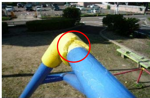
継ぎ手金具の破損
