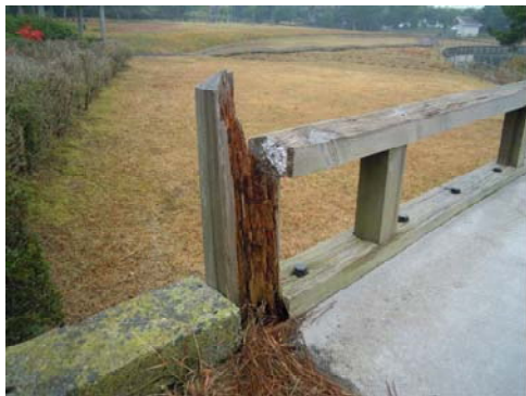
高欄（木）の腐朽
