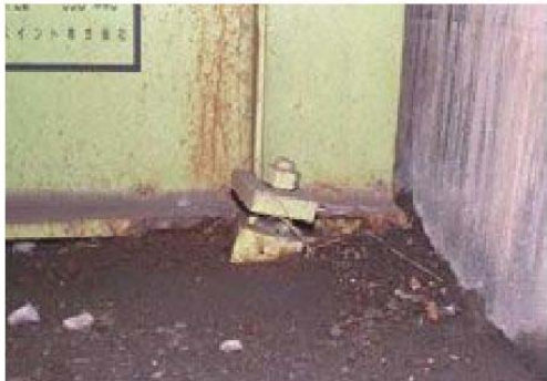
支承の機能障害
