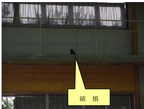
壁面仕上げ材の破損
