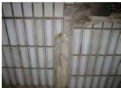
タイルの剥離
