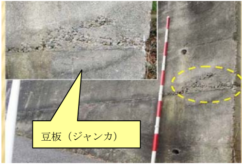
コンクリート初期欠陥
