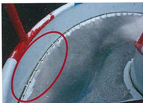
滑降部溶接部分の割れ
