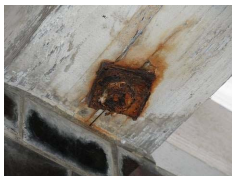
接続金具腐食
