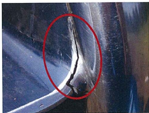
滑り降り部端部の亀裂
