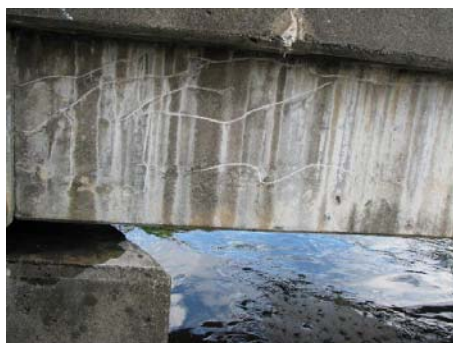
PC 桁のひびわれ
