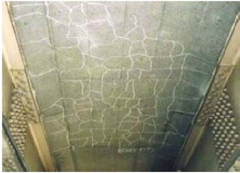
RC 床版のひびわれ
