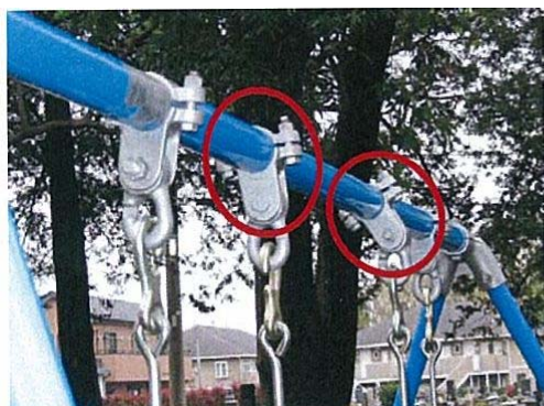
吊金具のずれ
