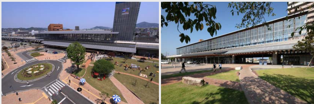
日向市駅（左：全体俯瞰、右：駅舎）。デザイン会議での議論により、駅舎、駅前広場、高架橋等の一体的なデザインが実現されている。
