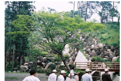
2002年造成直後の様子 (積み上げられた石の部分が擁壁)
