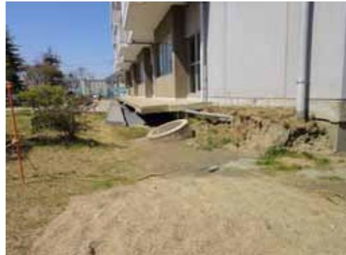
写真-4 建物の基礎地盤の沈下
