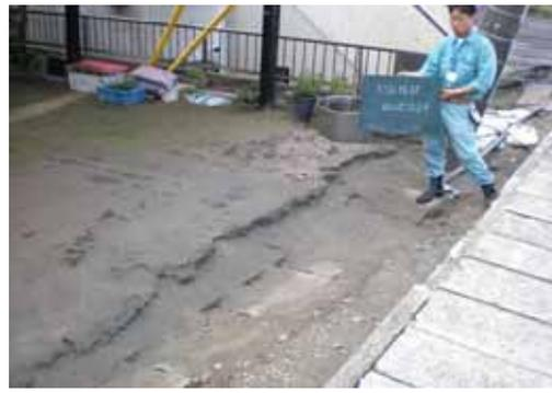
写真-2 宅地地盤の液状化に伴う大規模な噴砂状況
