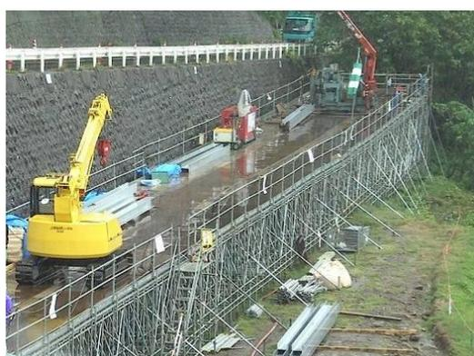
写真一 5 手すり先行足場の施工例
