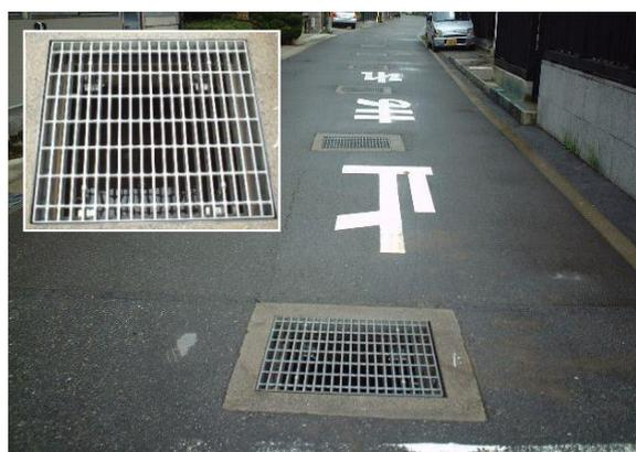
写真-5 縁塊・排水柵の設置例(SPM)
