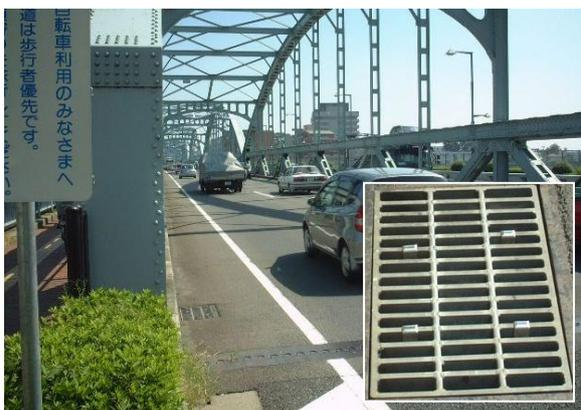
写真-4 橋梁・排水柵の設置例(SSP)
