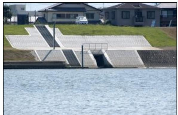
写真-3. 樋門ゲート設備 (樋門全景)
