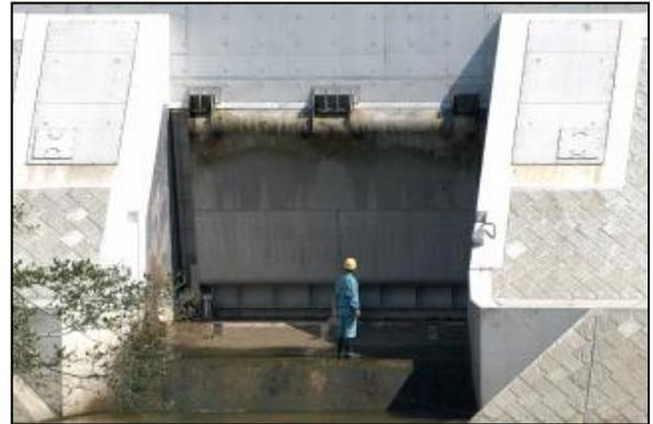
写真-1. 樋門ゲート設備 (W6.00m×H3.10m)
