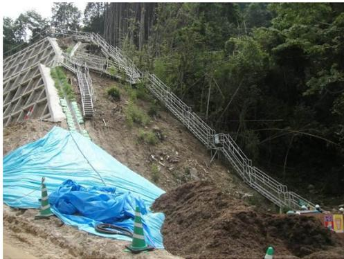
写真一 1 法面工所用昇降設備
