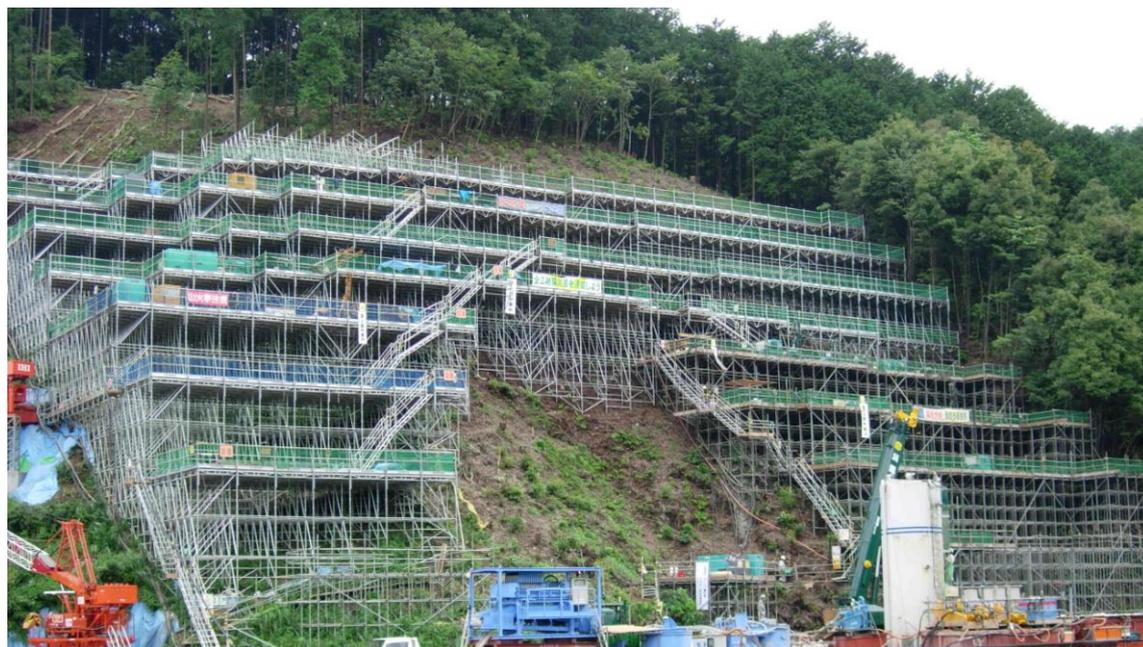
写真一 4 作業構台での施工例
