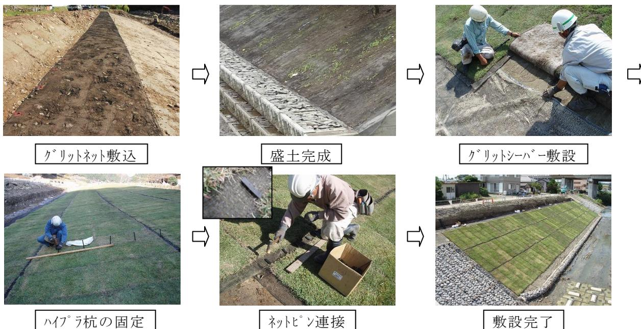
写真-1 グリットシーバー工の施工フロー
