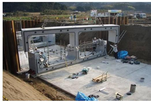
写真-4 落谷川樋門（弾性接合方式）
