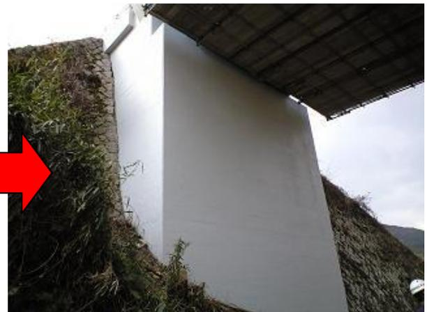
写真三 橋梁橋脚補修工事（施工前→施工後 グレー色タイプを使用）
