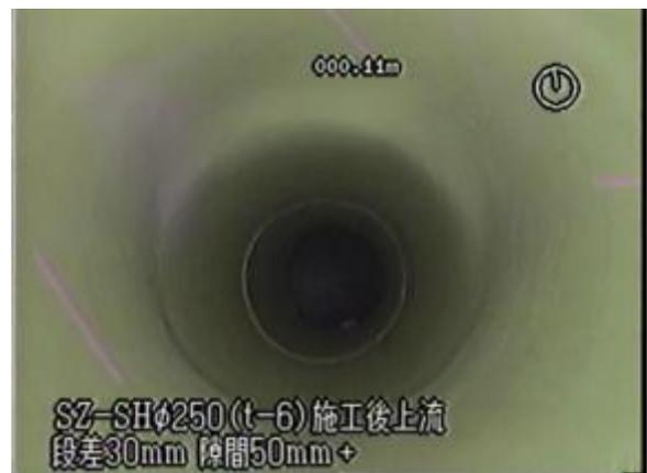
写真一 4 段差、隙間への施工
