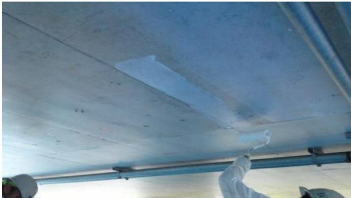
写真一 塗布状況（橋梁床版下面）
