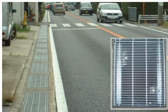
写真-3 道路側溝の設置例(SPミニ)
