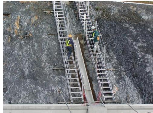
写真一 2 砂防流路工所用昇降設備
