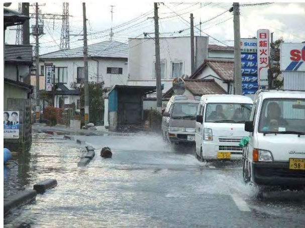
地盤沈下による道路冠水状況（１）
