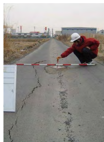
液状化対策施工（被害有り） 写真 I-1-24
