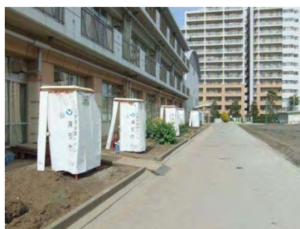
日の出中学校(災害用トイレ設置)
