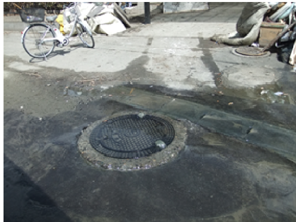
写真 I-1-31 人孔からの溢水の状況（宮城県七ヶ浜町内）
