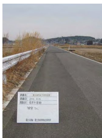
液状化対策施工（被害なし） 写真 I-1-23
