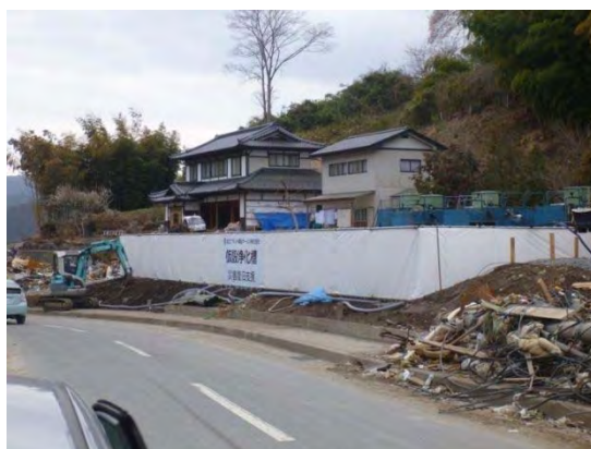
写真 I -1-47 仮設処理場設置現場
