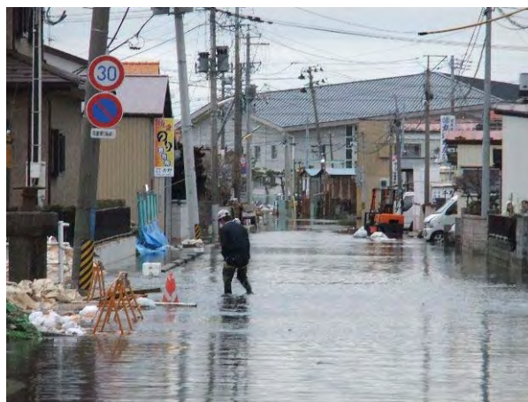
地盤沈下による道路冠水状況（２）
