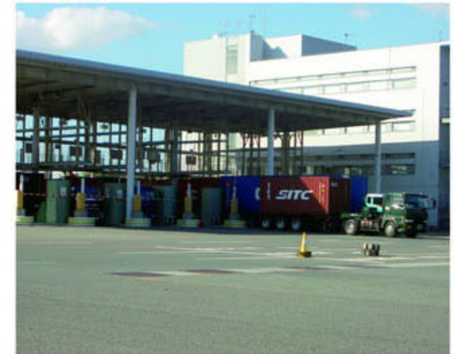
コンテナターミナルのゲート。各トラックはここで入場手続を済ませる。
