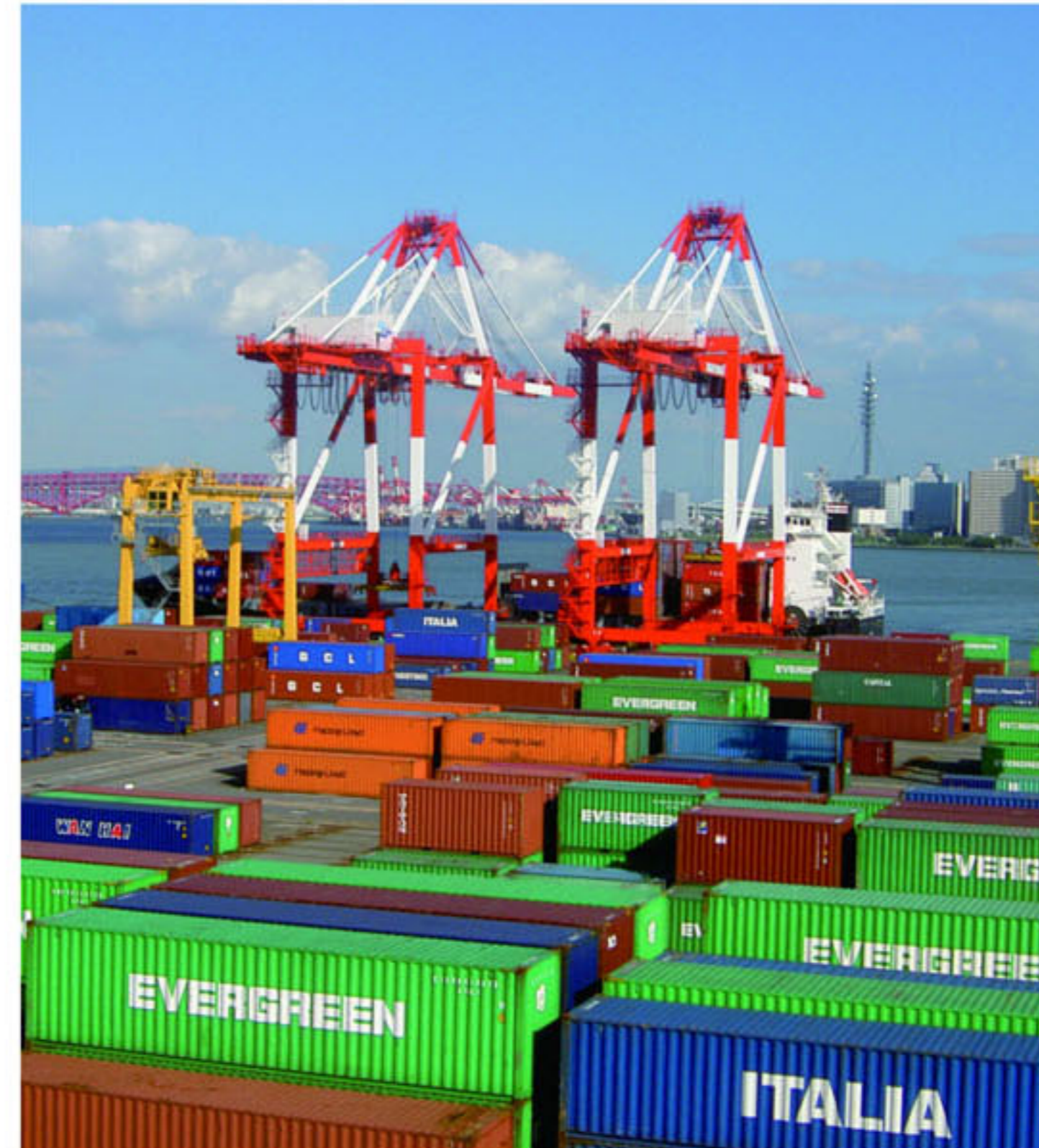
コンテナが整然と積まれた阪神港のコンテナターミナル。岸壁にある大型のガントリークレーンで、荷役作業を行う。
