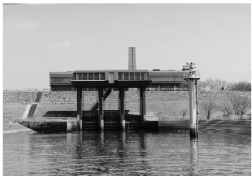
(新芝川排水機場樋管)
