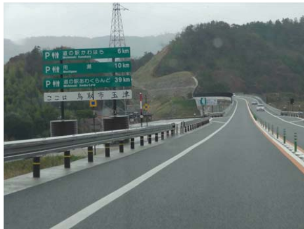
路外の道の駅への案内表示事例（鳥取自動車道）
