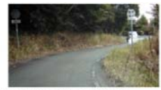
① 1車線の道路で急カーブが連続。 ② 路肩が狭い。
