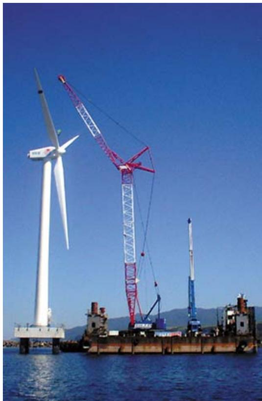
図 2-1-9 SEP 船による風力発電施設据付作業状況（北海道・せたな町）
