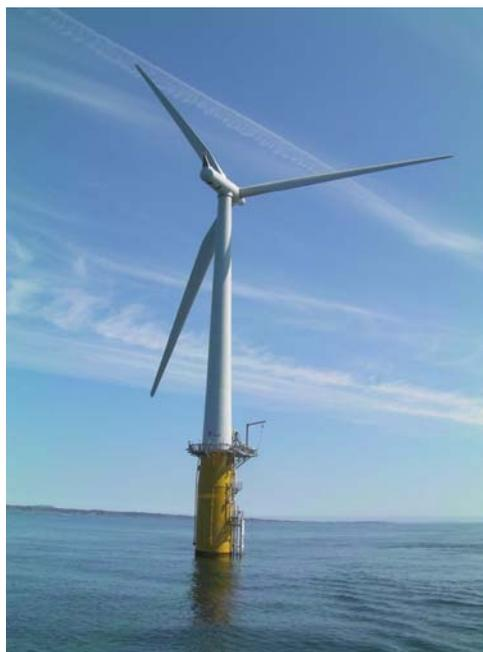
図 2-1-11 浮体式洋上風力発電施設「Hywind」
