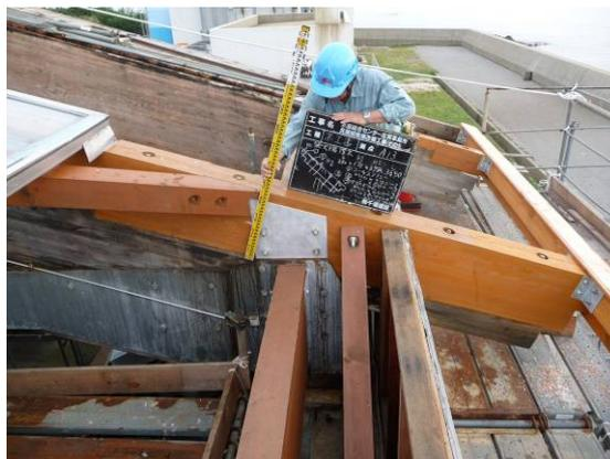
大梁（米松集成材 210×950～1,300）は梁天端の腐食部分を切り取り埋木補強。新部材と既存部材とをエポキシ樹脂系接着剤及びボルト等金物で接合
