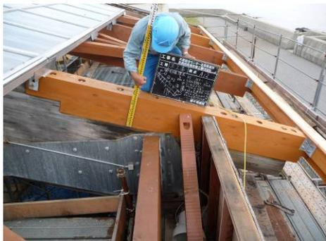
小梁（米松ムク材 150×360）は取替、又は天端の腐食部分を切り取り埋木（150×210程度）、下部を添梁（米松無垢材 150×300）で補強
