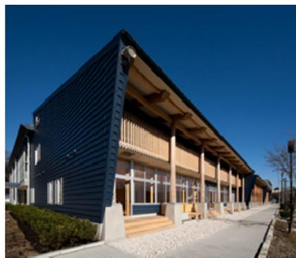
雨落ちは玉石側溝で対応
