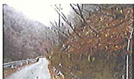
災害時に崩落の恐れのある箇所
