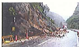
災害時に通行不能となった箇所
