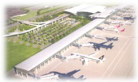
ノイバイ国際空港第2旅客ターミナルビル建設事業 (ベトナム・ハノイ)
