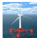
浮体式洋上風力発電施設
