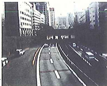
▲走行車線間に橋脚が立つ亀井橋
