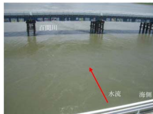
4号堰柱から百間川を撮影
