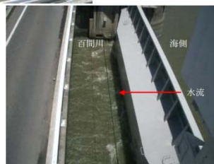
4号堰柱から3号ゲートを撮影
