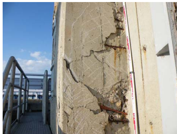
門柱部のコンクリ剥離、鉄筋露出状況
