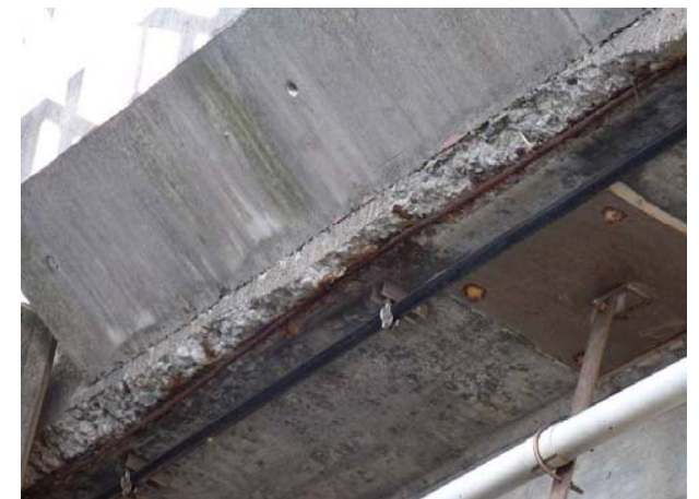
管理橋地覆部のコンクリ剥離、鉄筋露出状況
