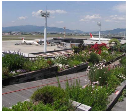
■旅客ビル屋上緑化
