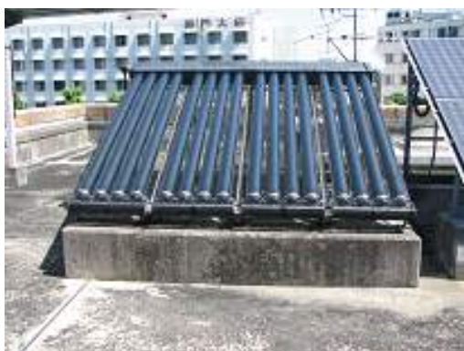
■太陽熱温水器の設置
