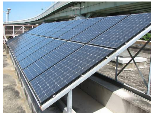
■太陽光発電の設置
