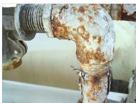
腐食した給水管
