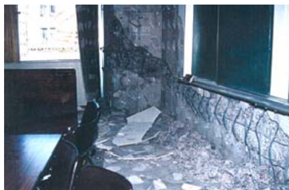
内部の被災状況
