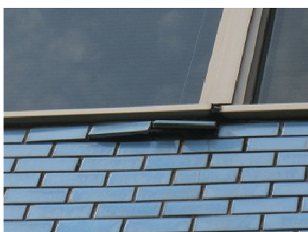
落下のおそれがあるタイル
