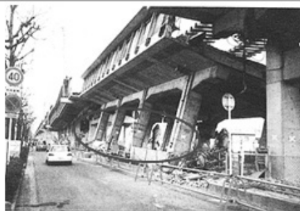
柱が折れ倒壊した高架橋 (山陽新幹線)
