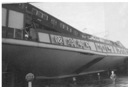
高架の倒壊とともに崩落した駅 (阪急電鉄 伊丹駅)
