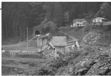
北リアス線島越駅の被害
