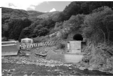
南リアス線荒川橋りょうの被害
