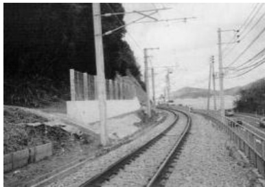
【落石防止擁壁の一例】
