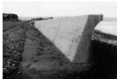
【護岸壁の一例】
