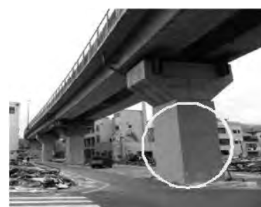
< 橋脚の耐震補強 >
