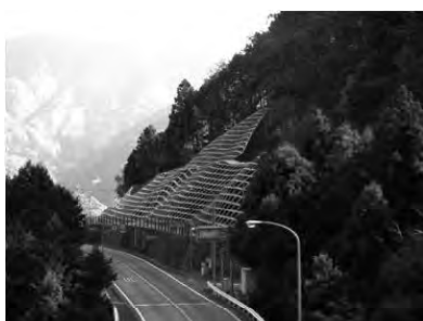
< 斜面崩落防止対策 >
