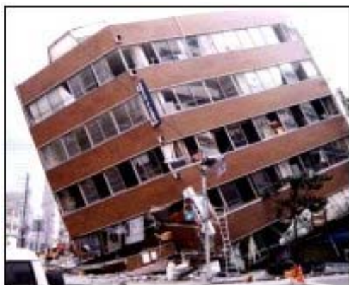
事務所ビル1, 2階の崩壊
