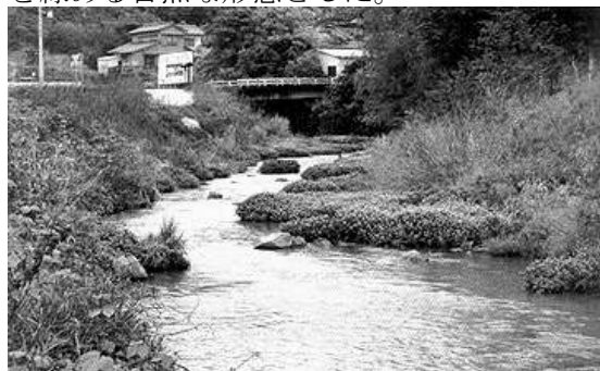
施工後1年10カ月
