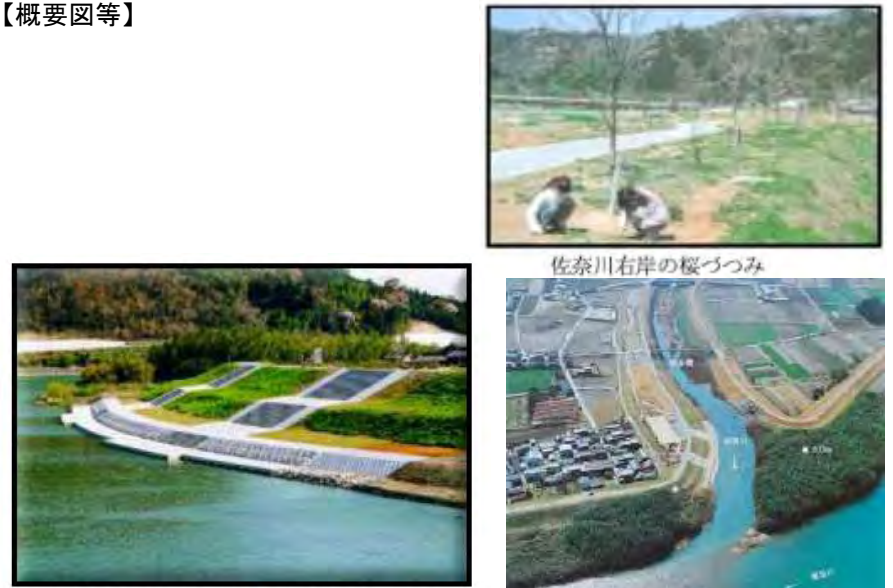
榑田川合流部(船着き場を兼ねた護岸)
