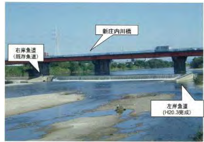
小田井床止 左岸魚道遡上状況（新設）
