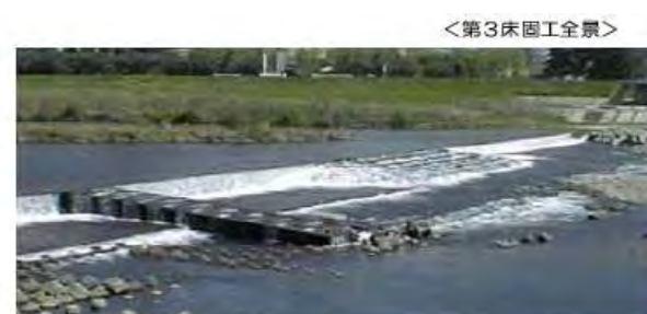
(右側: 既設の階段式魚道、中央: 棚田式魚道)
