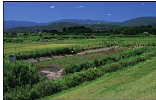
湿地の再生の試験施工の様子
