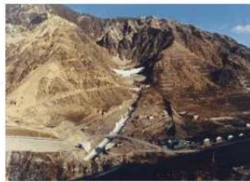
山腹工施工前(昭和62年)
