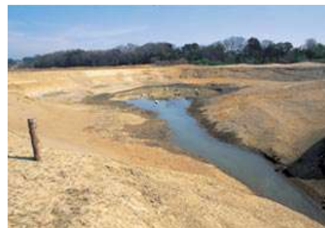
水路整備直後（1997 年 2 月）
