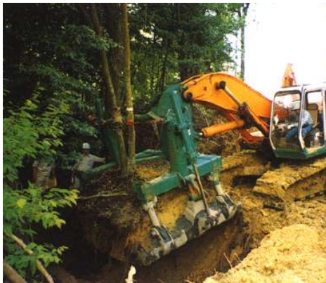
移植用重機による根鉢の掘取 （日本道路公団等パンフレット）
