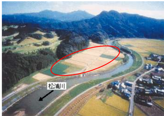
アザメの瀬 再生前
