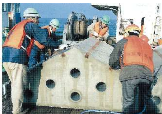
藻礁ブロックへの種系の貼り付け (海の自然再生ワーキンググループ, 2003)
