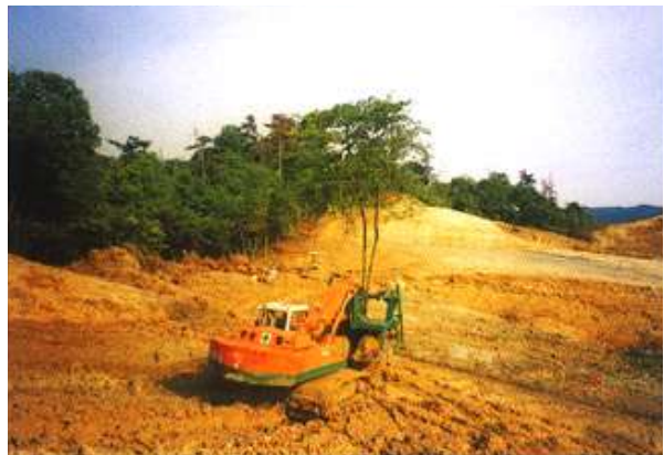
移植用重機による樹木の運搬 （日本道路公団等パンフレット）
