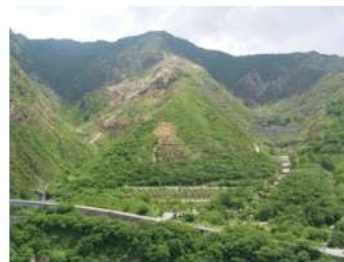
山腹工施工後(平成18年)
