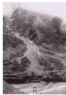
荒廃状況(昭和12年)
