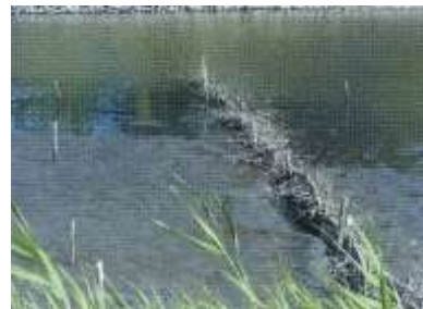
干潟面に設置した土砂堆積促進用粗朶
