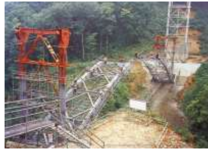
ケーブルによる資材運搬
