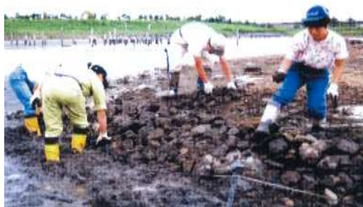
干潟面に配置した石積み (海の自然再生ワーキンググループ, 2003)
