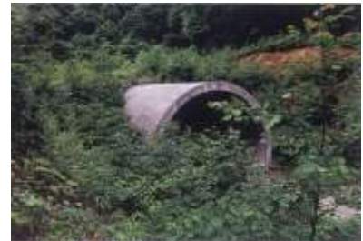
トンネル坑門工
