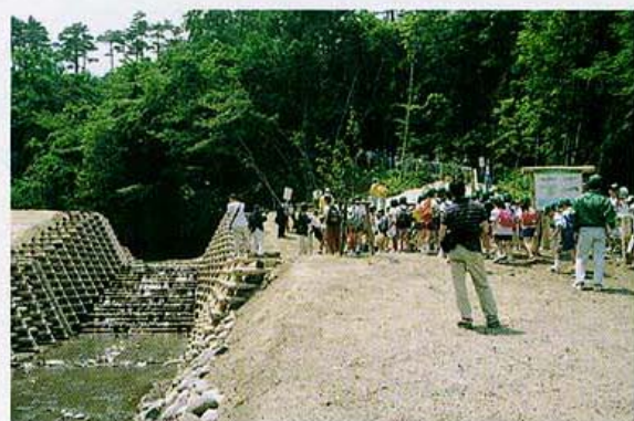
砂防えん堤探検隊
