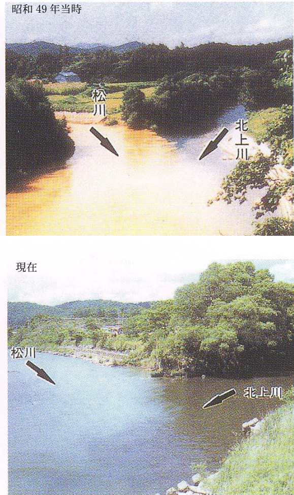
図6-6 昭和49年当時と現在の北上川・松川の合流状況
