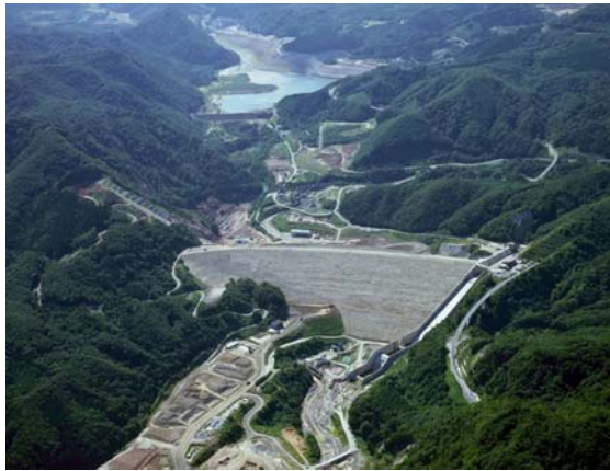
建設中の胆沢ダム
