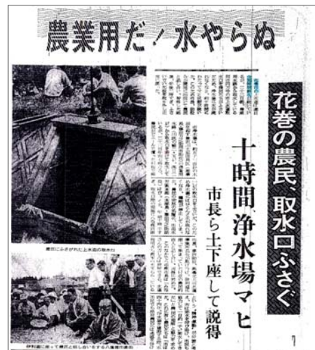
農業用水路から取水を行っている上水道取水口を農民がふさぎ、約10時間浄水場がマヒ
