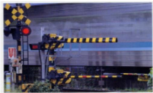
大型遮断装置＋二段型遮断装置
