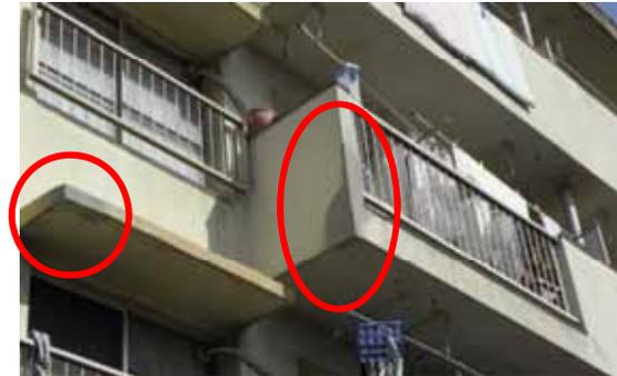
劣化が進行したバルコニーと底部の隅部が剥落・欠損するなど不具合が生じたため、部位ごとに補修を行っている
