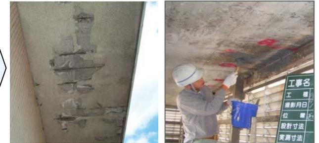
断面修復工法による補修
