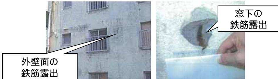
外壁面の鉄筋露出
