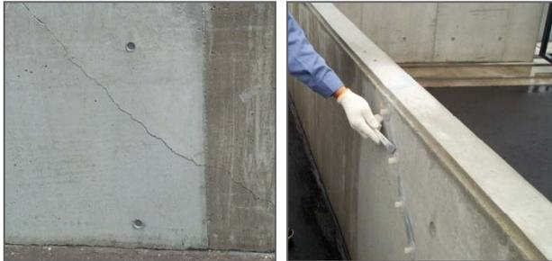
注入工法による補修
