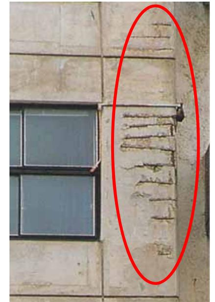
中性化によるひび割れの例
