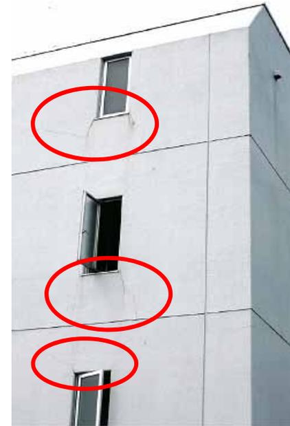
乾燥収縮によるひび割れの例
