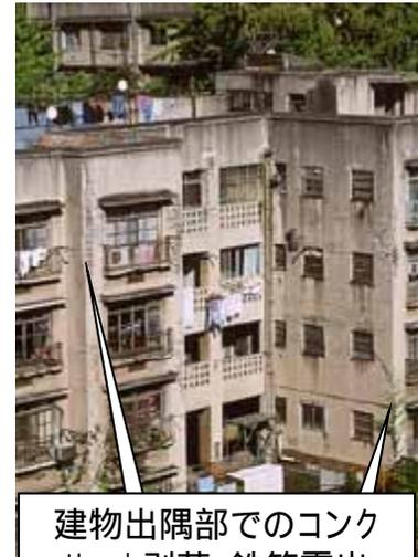
建物出隅部でのコンクリート剥落・鉄筋露出
