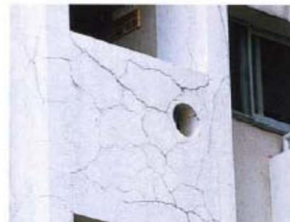
定期点検による外壁のひび割れ確認と原因の特定
