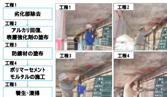
鉄筋腐食によるひび割れの補修事例
