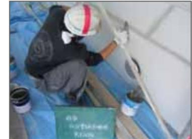
充てん工法によるひび割れ補修
