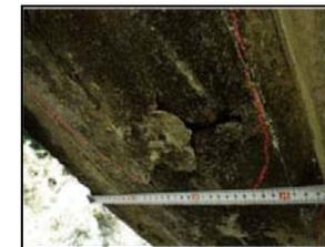
主桁の損傷状況(鉄筋露出)
