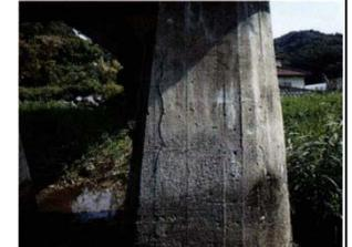
下部工の損傷状況(ひびわれ)
