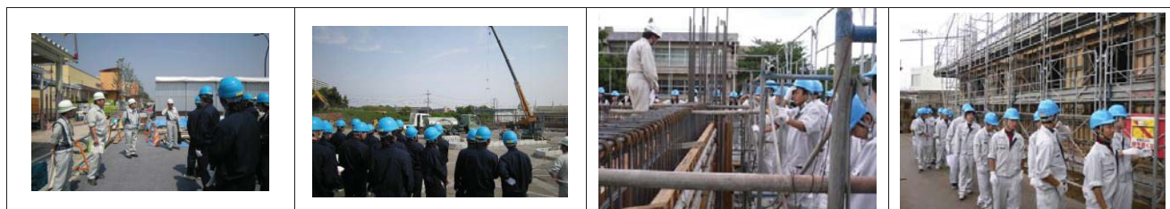
京葉道幕張 PA 改修工事
