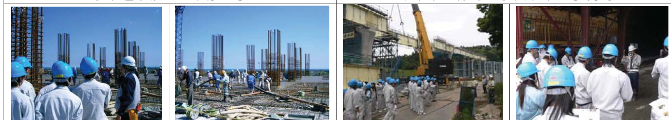
旭中央病院新本館建設工事現場
