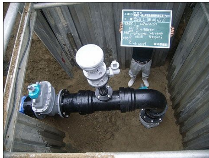
緊急連絡管の接続箇所(基山町側)
