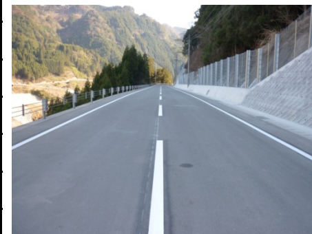
県道日田鹿本線改良事業
